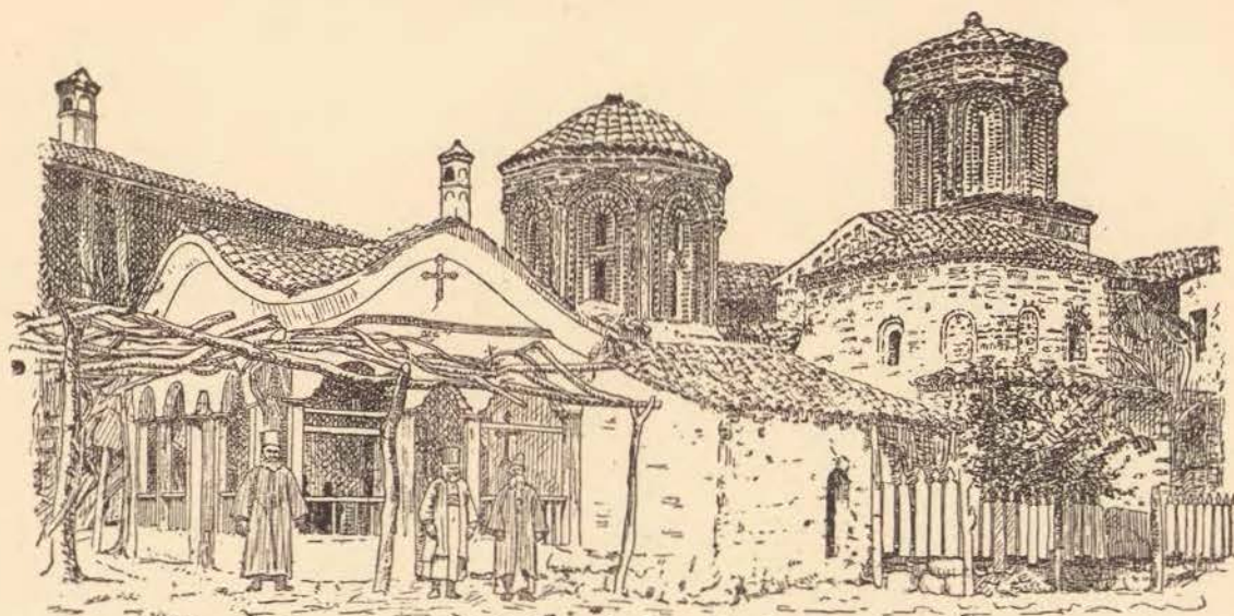
149. Saint-Naoum. Vue du sud-ouest. (Dessinée d'après phot. Kondakov).
